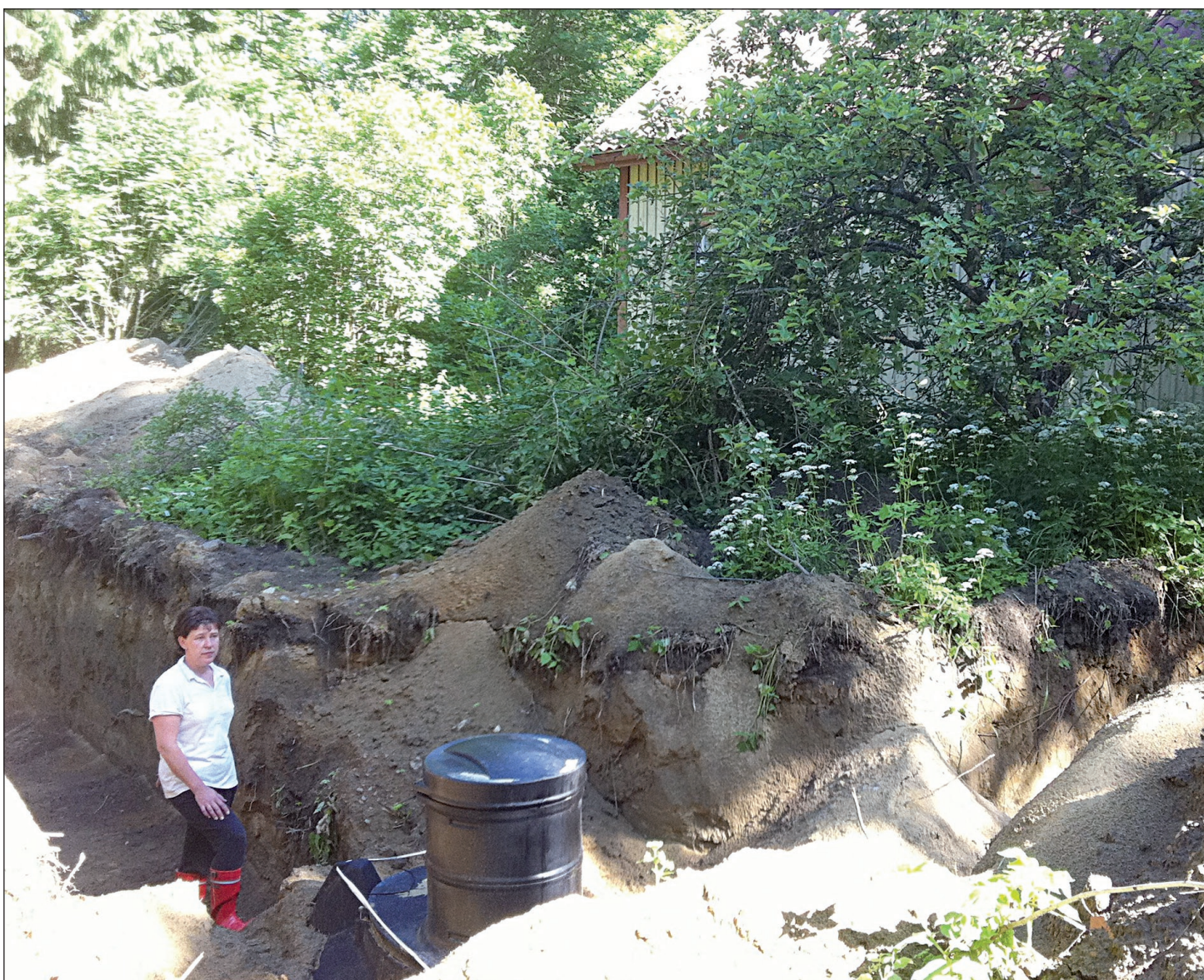
Soile Honkaraari mahtuu hyvin seisomaan suodatuskenttää varten tehdyssä kaivannossa. Saostuskaivot ovat jo paikallaan, mutta muut rakenteet puuttuvat. Suodatuskentälle tulee pituutta 20 metriä.
